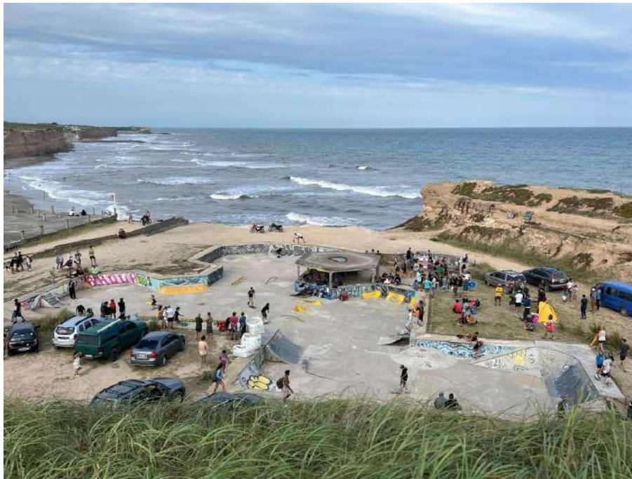
Fig. 2. Estructuras de hormigón abandonadas reutilizadas y restauradas como skatepark ("Paradise DIY"). Foto: Mecu Videla.
